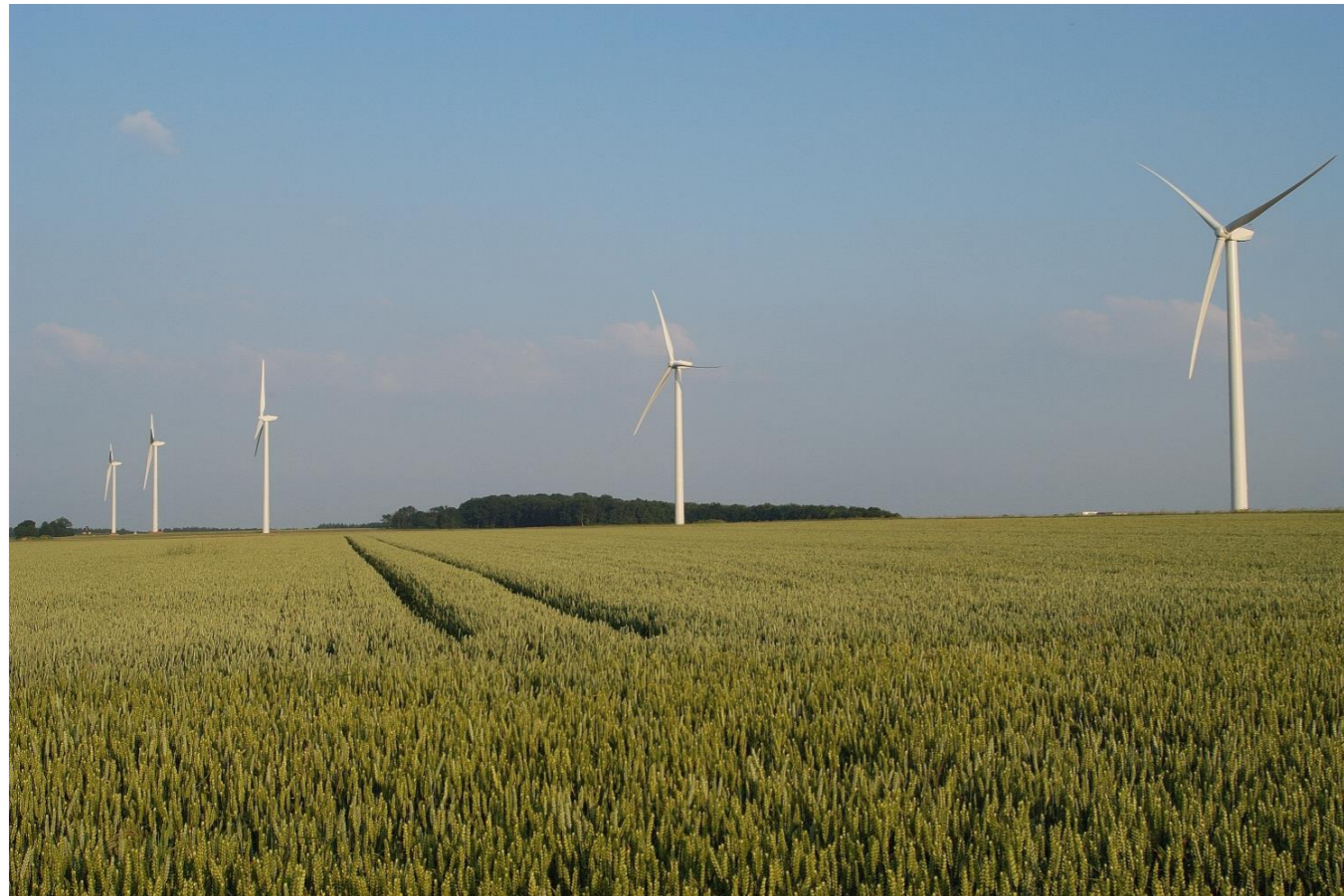
Photo 72 : Vue générale d'un parc éolien en plaine (VALOREM)
