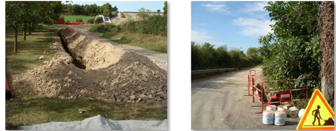
Photo 74 : Tranchée pour le raccordement au réseau local (Source : VALOREM)
