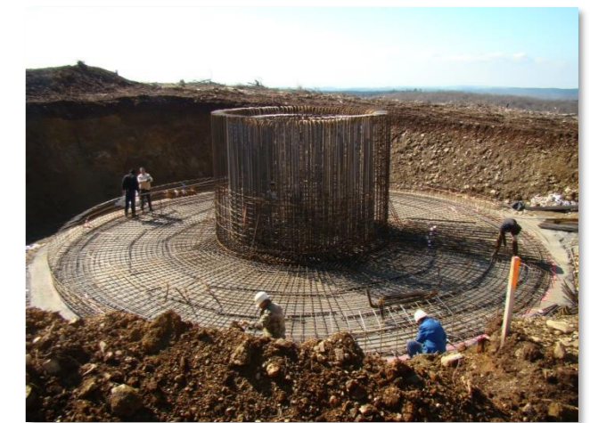
Photo 76 : Armature (VALOREM)
