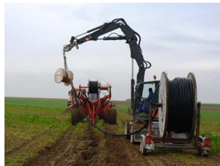
Photo 84 : pose d'un câble HTA à 1,20 m avec la méthode du soc tracté (source VALOREM)
