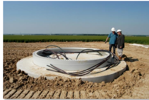
Photo 78 : Fondation terminée (VALOREM)
