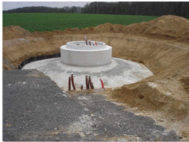
Photo 77 : Béton terminé (VALOREM)
