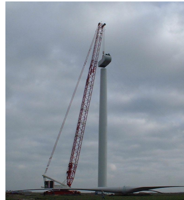
Photo 82 : Installation de la nacelle (VALOREM)
